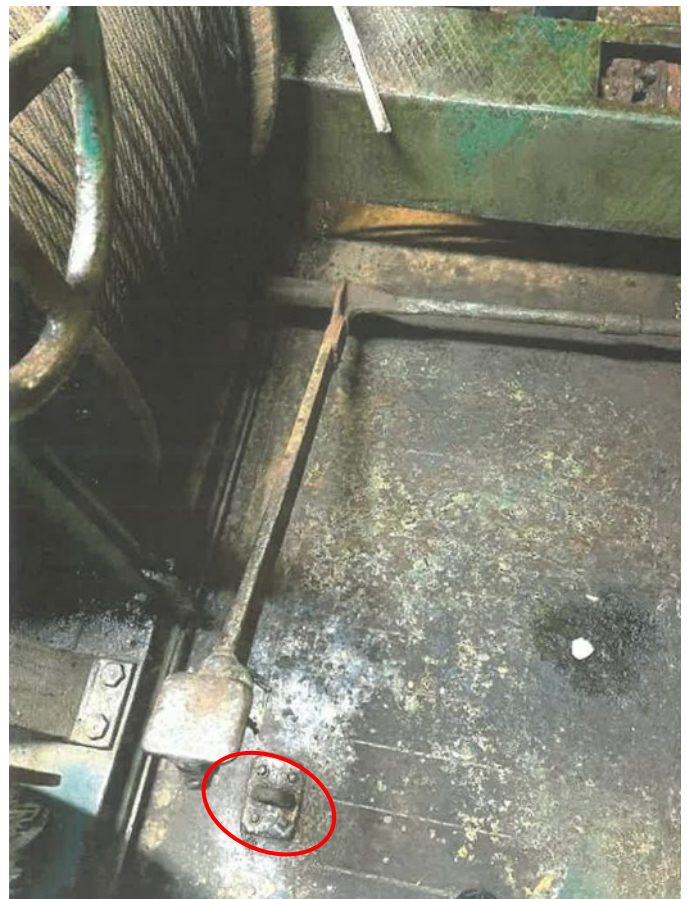
Εικόνα 14: Το ποδοστήριο για τον έλεγχο του μηχανισμού τάνυσης. Διακρίνεται η διάταξη για τη μόνιμη συγκράτηση στη θέση τάνυσης.
